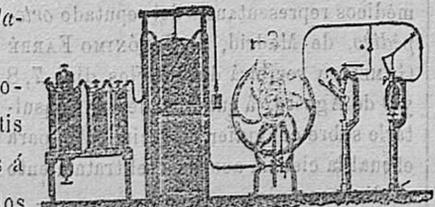
Aparatos para hacer gaseosas, contínuo con embotelladora en columnas independientes.
