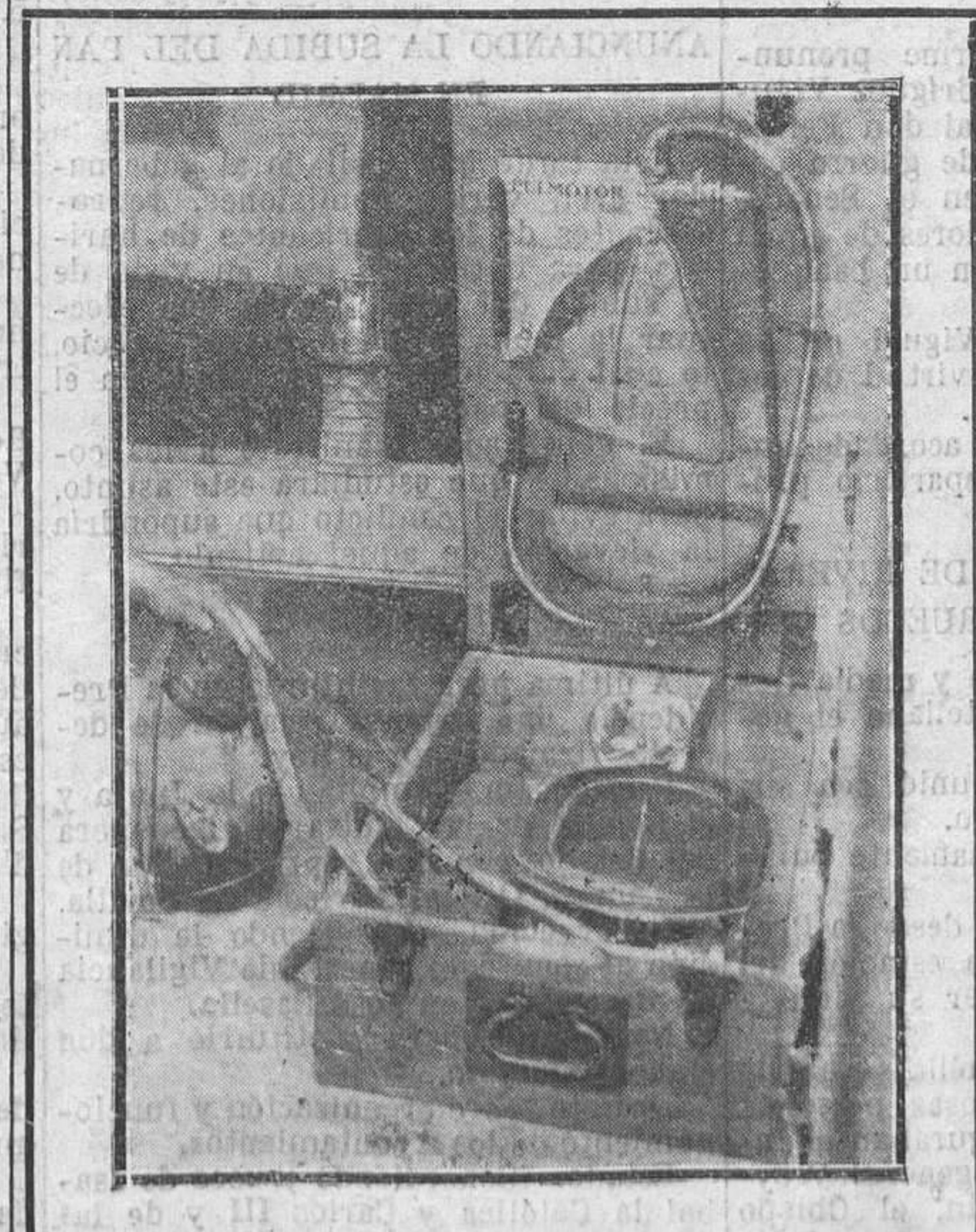
SAMA DE LANGREO.—Aparato pulmóor de la brigada de salvamento que se emplea en casos de asfixia. Úsase para practicar la respiración artificial (Foto Couso)
