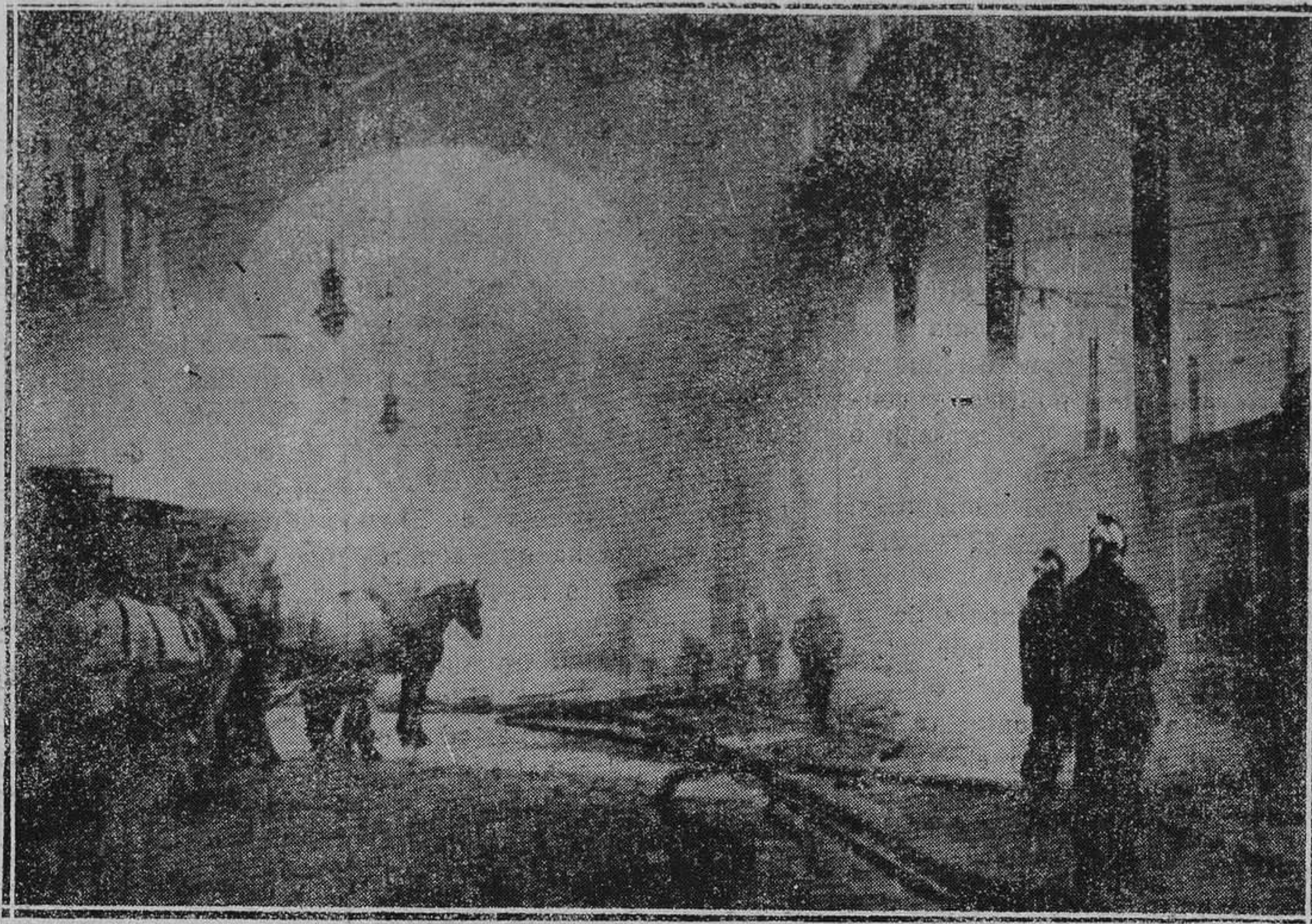
PARIS: DEL INCENDIO EN LOS MERCADOS CENTRALES.—Trabajos de extinción del siniestro que destruyó gran parte de los subterráneos del Pabellón de legumbres.
