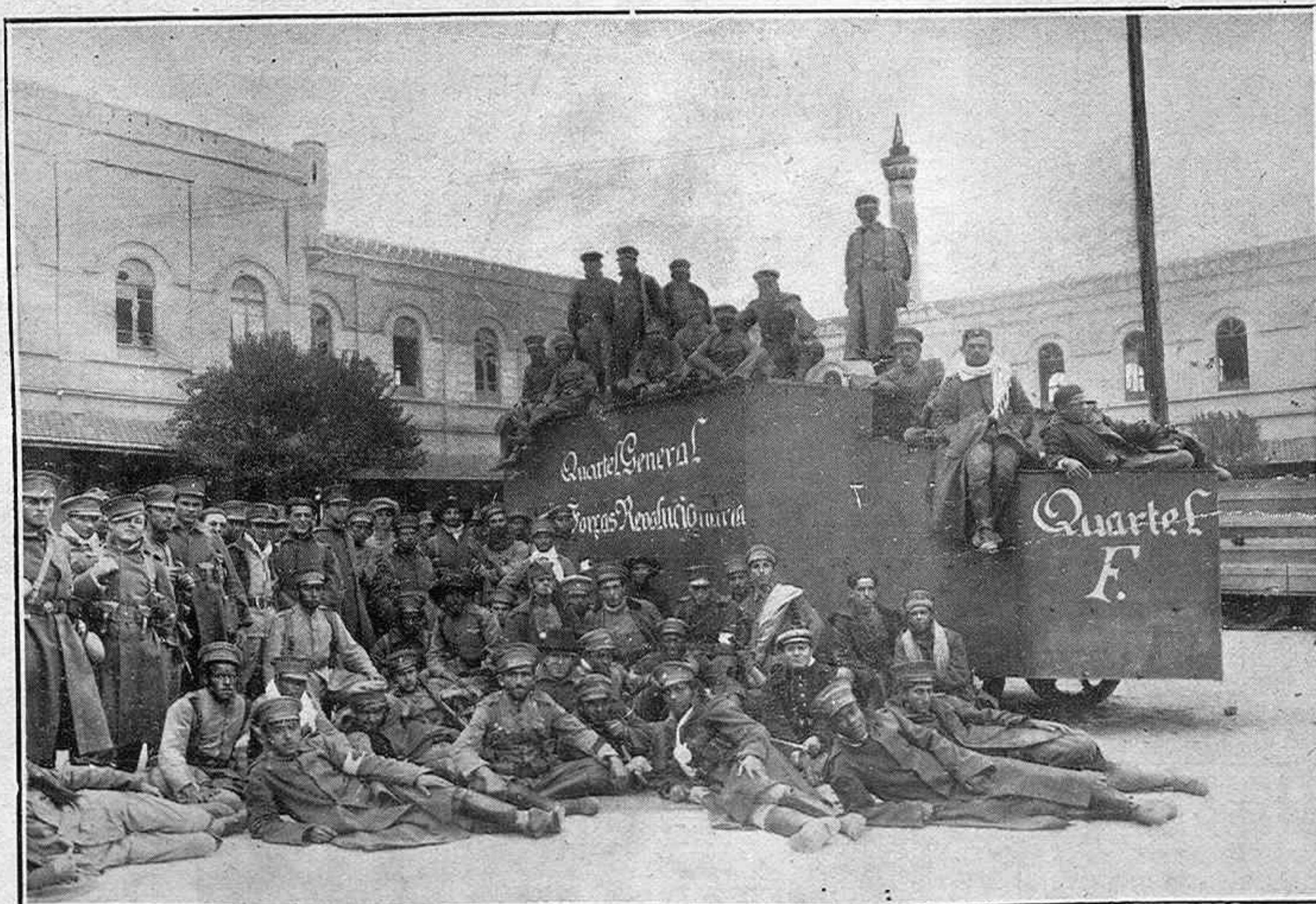
Un tanque construido por los rebeldes
