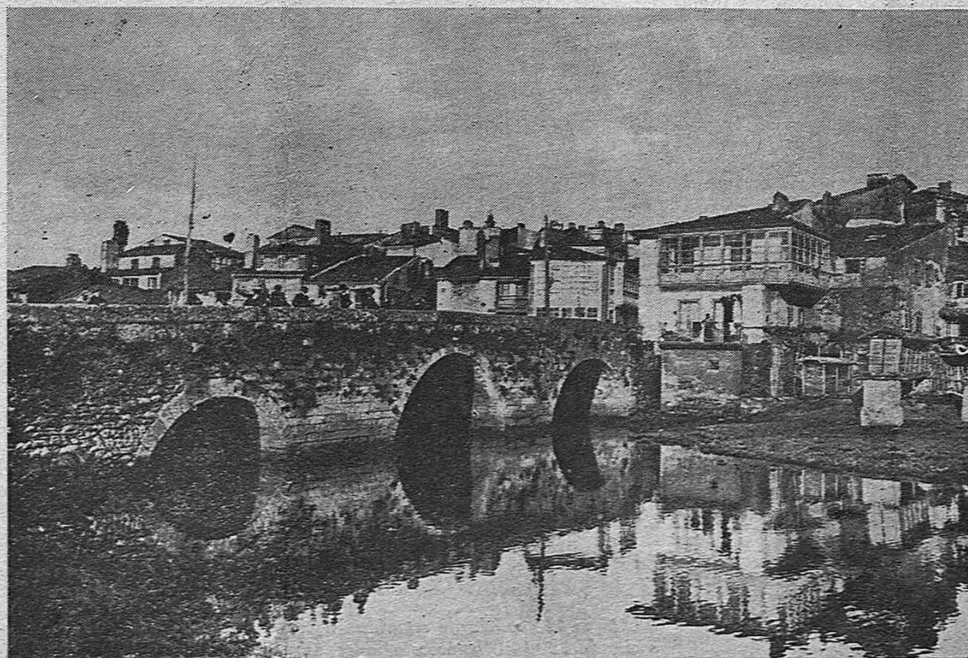
Betanzos, en Galicia. Una vista del puente sobre el río Mandeo.
