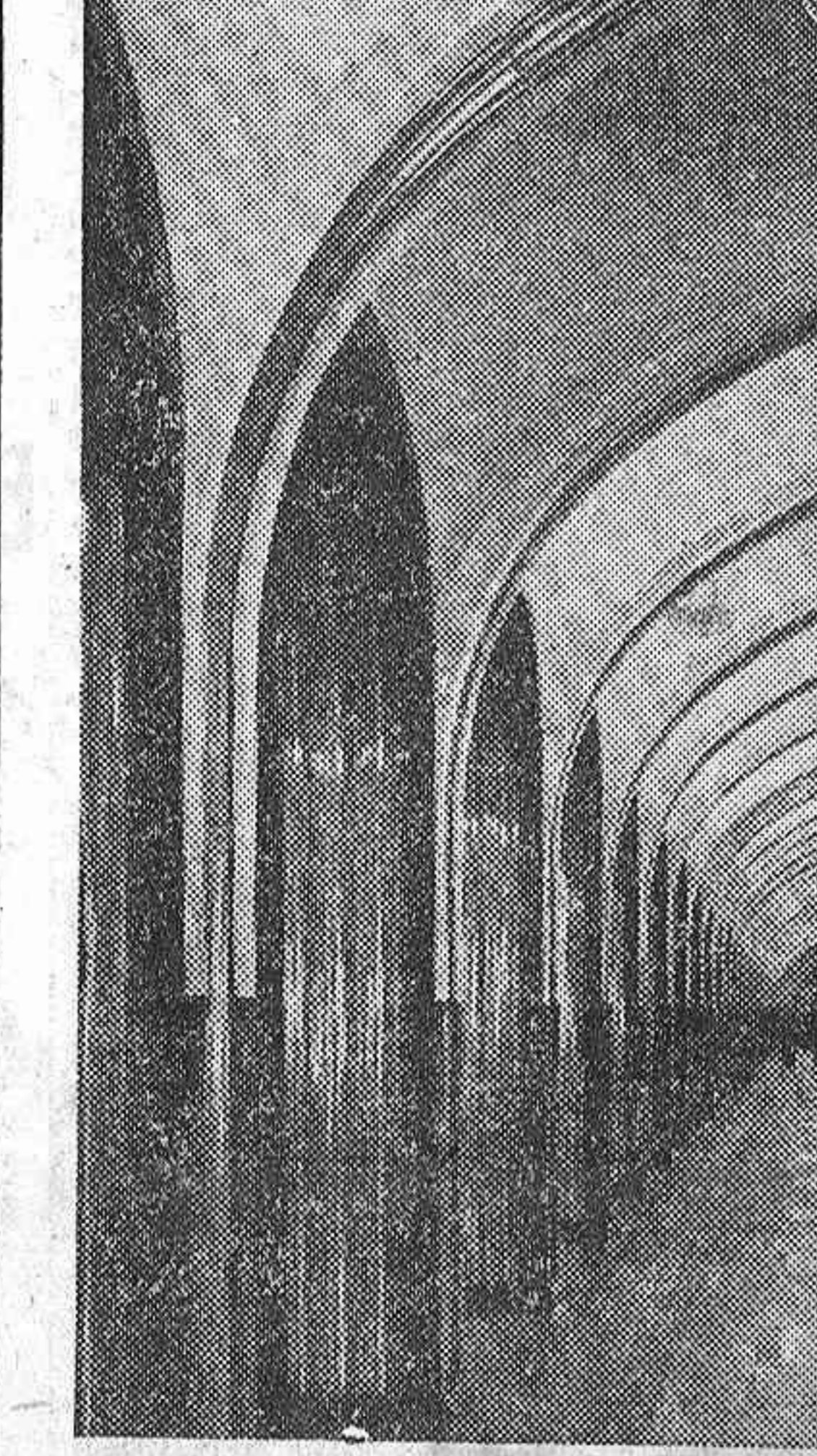
Magnífica perspectiva de la estación «Malakovskij» del Metro de Moscú cuya nueva línea será inaugurada en 1949.
