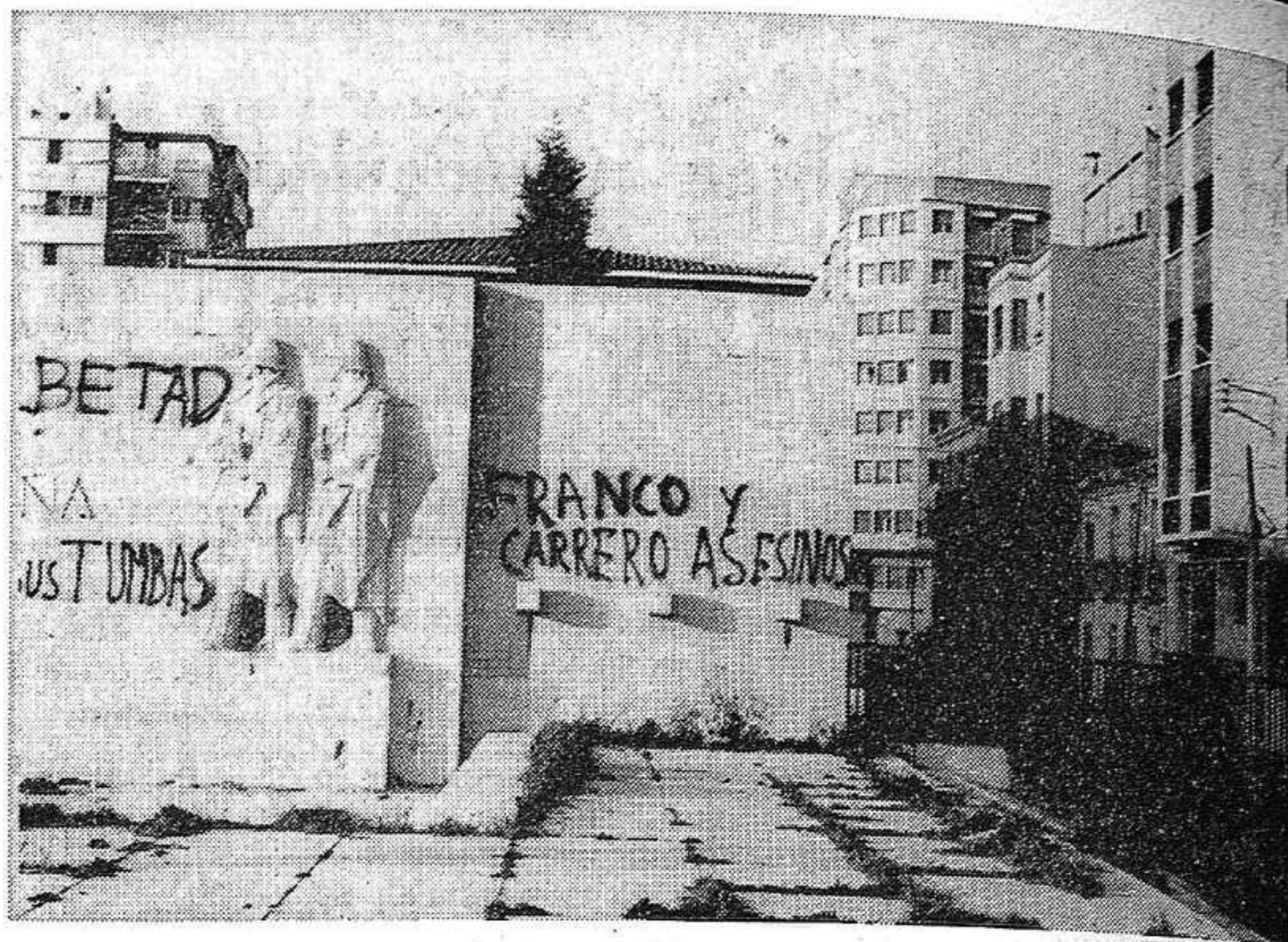
Cuando los muros de Zaragoza claman verdades.
