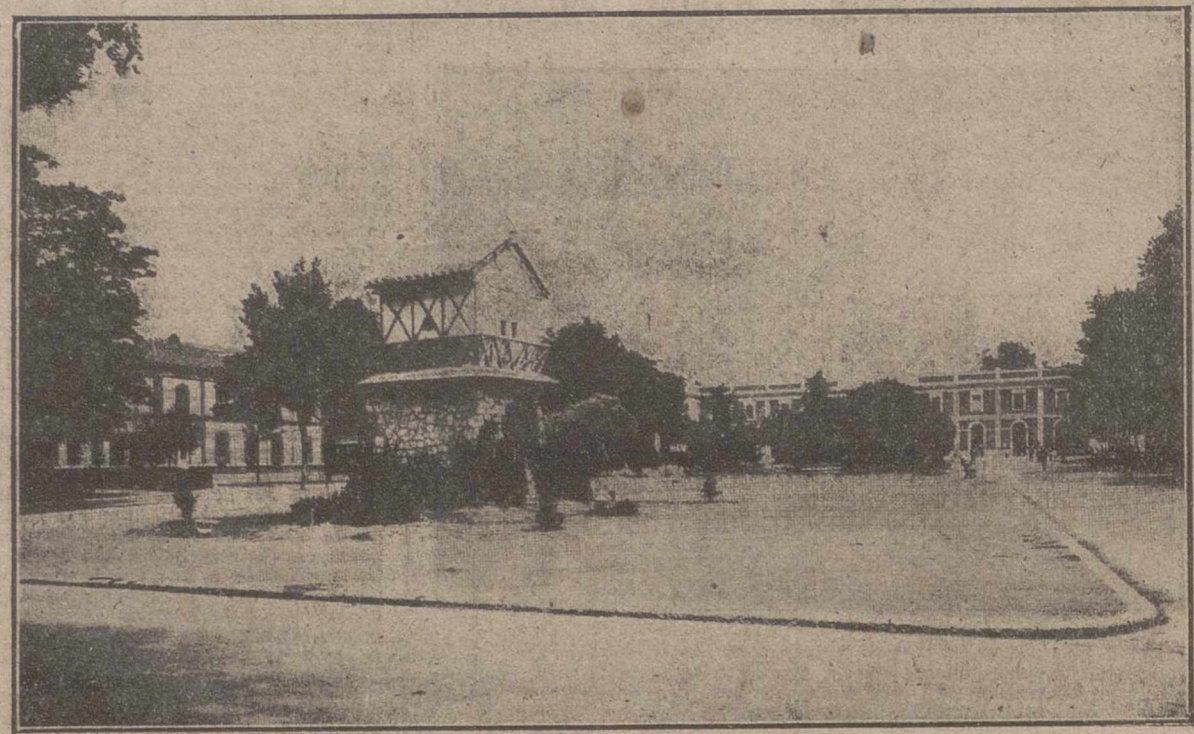
Una de las zonas de los «Jardinillos» —la puerta ferroviaria de Palencia— incluida en el nuevo plan de iluminación proyectado por el Ayuntamiento y que se llevará a cabo simultáneamente con la urbanización y arreglo de los paseos que confluyen a la Estación, de acuerdo con la Renta y los Secundarios. — (Foto Payá).
