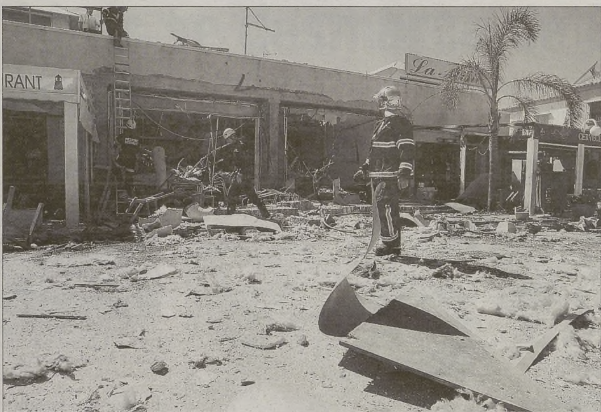
Un bombero observa la zona afectada por la explosión registrada en un bar de Chiclana de la Frontera. / JORGE ZAPATA (EFE)
