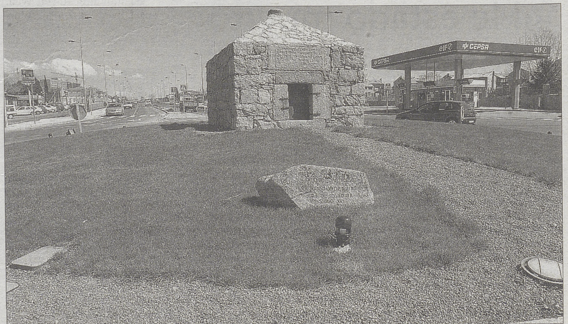
Registro del antiguo acueducto de las Hervencias. / TRUCHUELO
