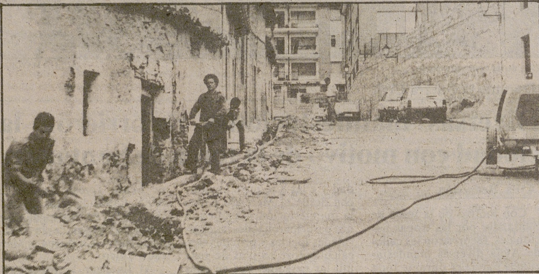
Obras de la nueva acometida de agua en la calle Trinidad.
