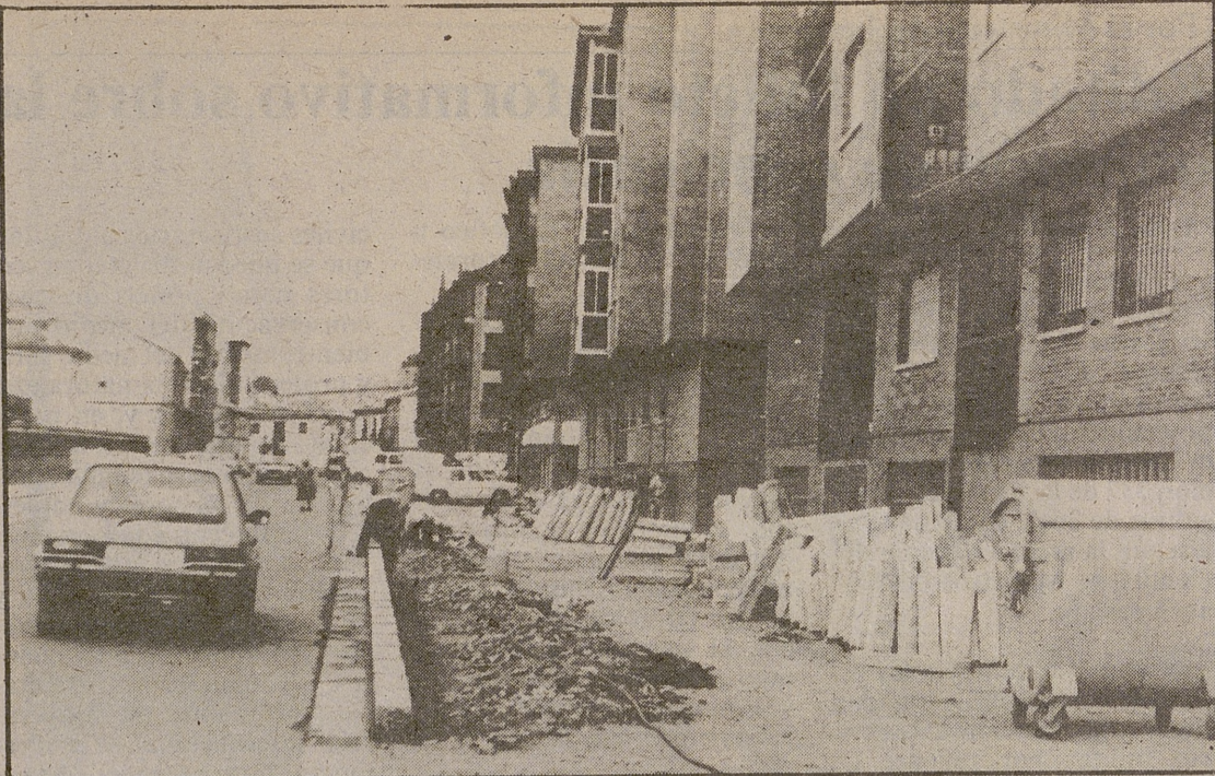
¿Por fin se verán terminadas estas obras?
