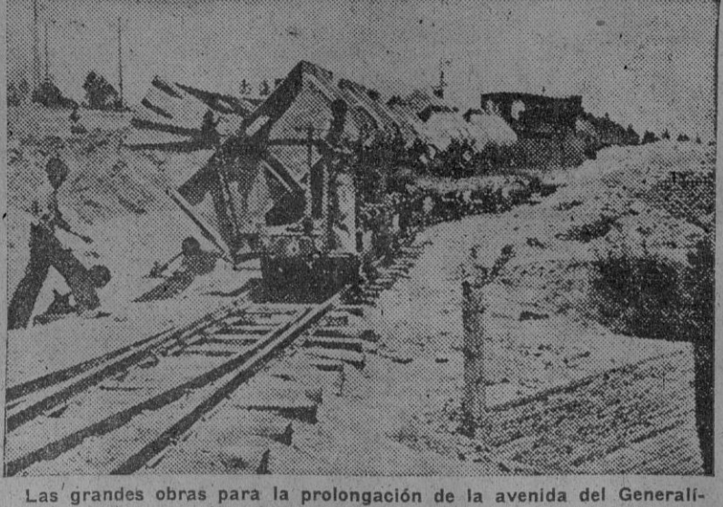
Las grandes obras para la prolongación de la avenida del Generalísimo siguen su ritmo acelerado y en ellas trabajan cientos de obreros. (Foto Diego).
