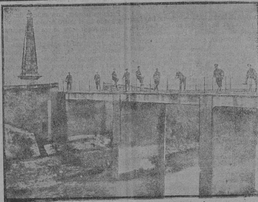
Puente construido sobre los restos del de Arcola.
