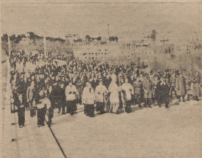
El ministro de Obras Públicas, señor Peña, con el general Orgaz y las demás autoridades, inaugura el puente construido por la España de FRANCO en sustitución del que fué volado por los rojos hace un año en Martorell. El puente fué bendecido por el Obispo de Barcelona. — El ministro, con el general Orgaz, Obispo de Barcelona y demás autoridades, cruzan el puente en el acto de la inauguración. (Foto CIFRA)
