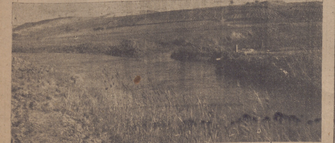
El canal, en las cercanías de Encinas de Esgueva, después de las obras de limpieza y ensancho efectuadas recientemente.
