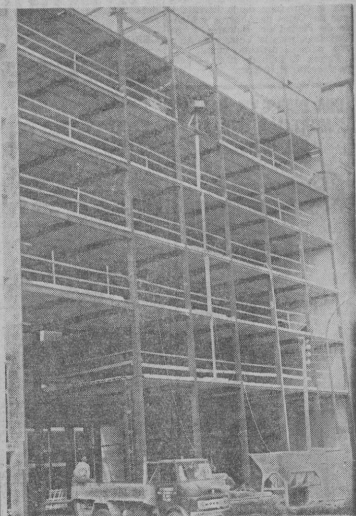
ESTRUCTURA METALICA DEL EDIFICIO BANCO DE VIZCAYA.
