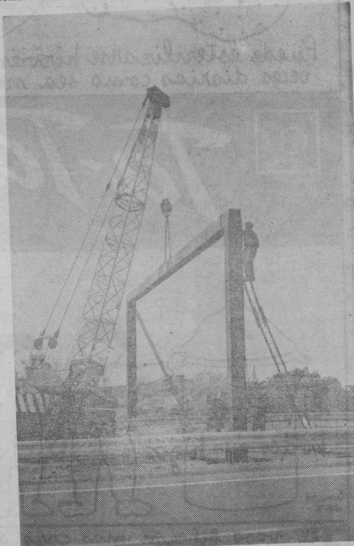
MOMENTO DE COLOCACION DE UNO DE LOS PORTICOS INDICADORES, DE LA AUTOPISTA PALMA-SAN JUAN, REALIZADOS TAMBIEN POR «ESTRUCTURAS METALICAS ADROVER, S. A.»
