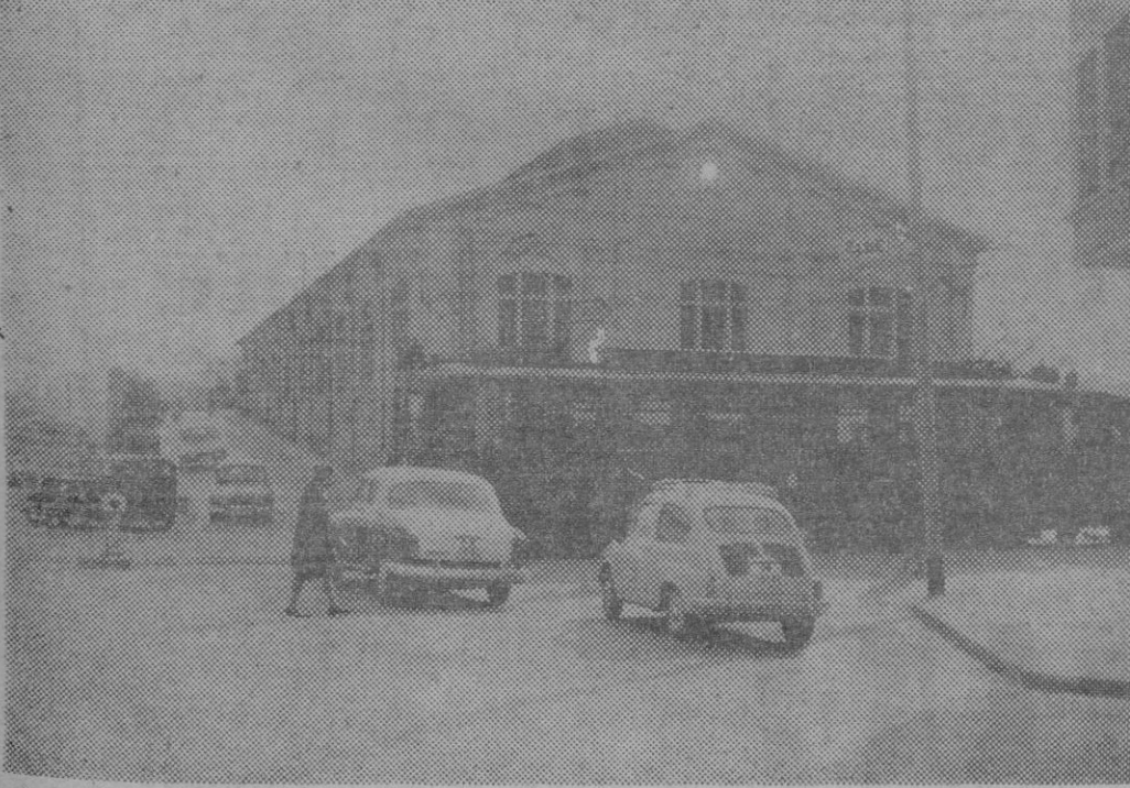
OTRA VEZ, SOBRE EL TAPETE DE LA ACTUALIDAD, EL «PUENTE DEL TREN». PARECE QUE, EN 1966, QUEDARA SOLUCIONADO ESTE ENLACE ENTRE LAS ZONAS DE LEVANTE Y PONIENTE. POR ENCIMA DE ESTE PUENTE ESTRECHO, CIRCULAN DIARIAMENTE 10.000 VEHICULOS. Y LAS ACERAS, RESBALADIZAS, ENTRANAN MUCHO PELIGRO PARA LOS PEATONES.
