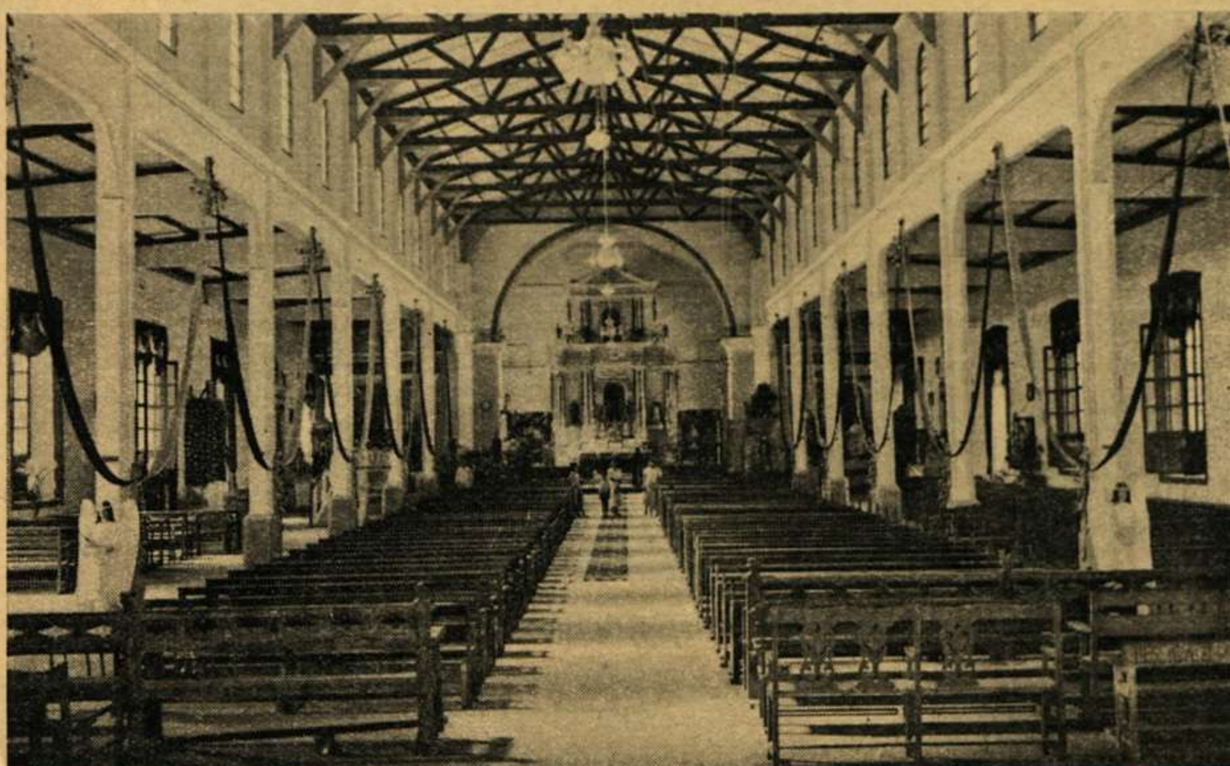
Iglesia de Dagupan recientemente reparada.
