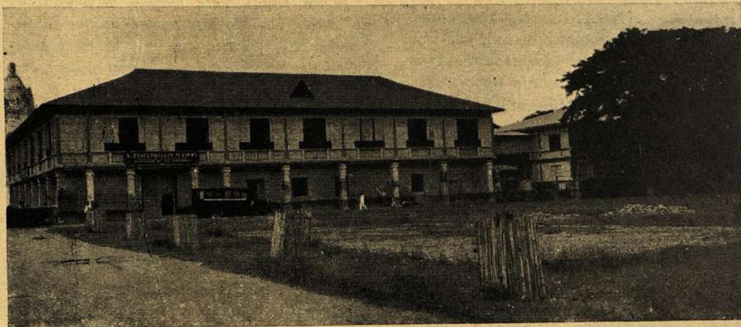
Convento de Dagupan recientemente reparada.
