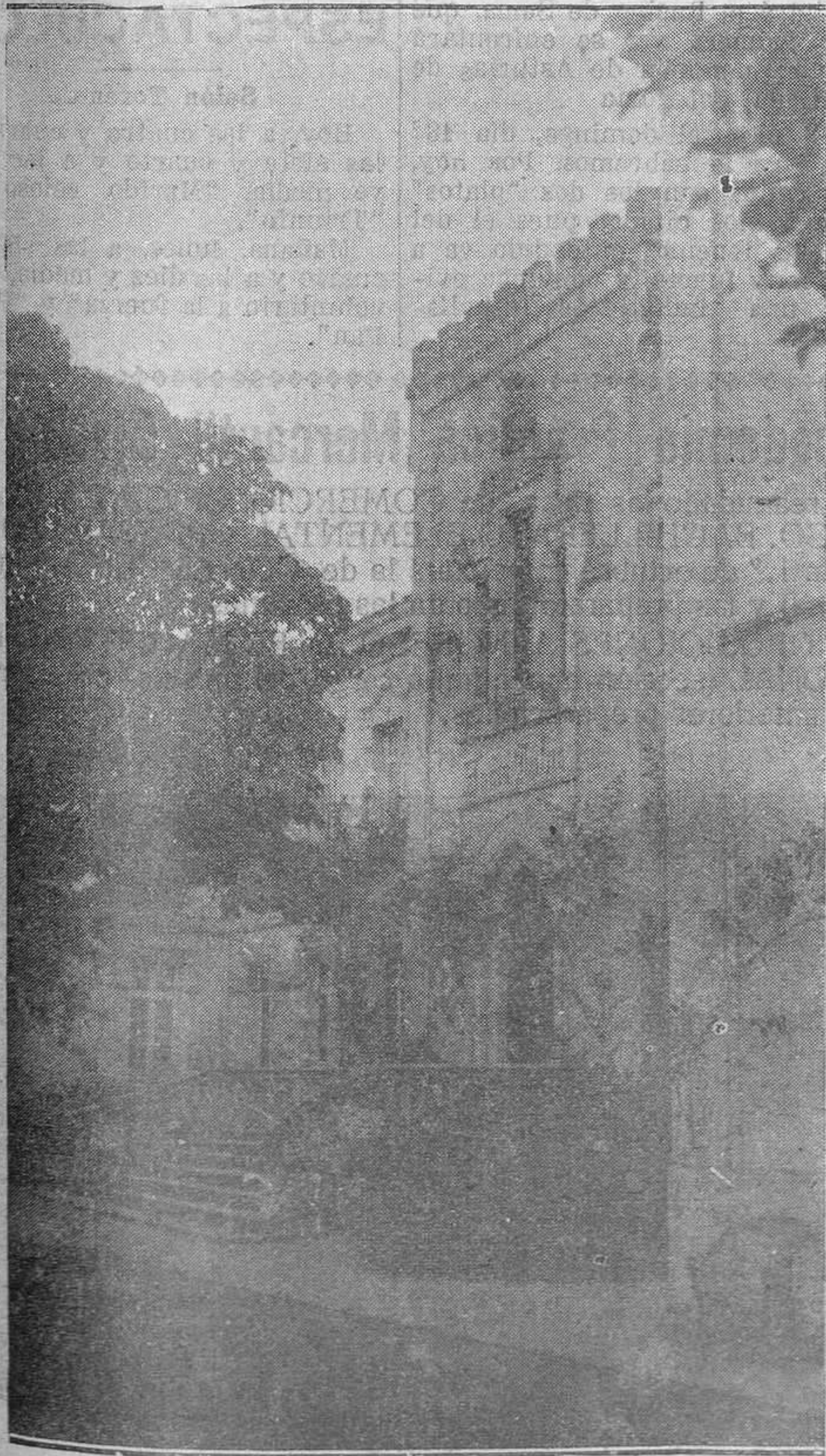
LAS MANSIONES ASTURIANAS: LA QUINTA DE LOS MARQUESES DE LA VEGA DE ANZO, EN GRADO. Fachada principal.
