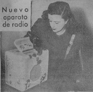
Aparato de radio con cuatro válvulas que funciona con batería.
