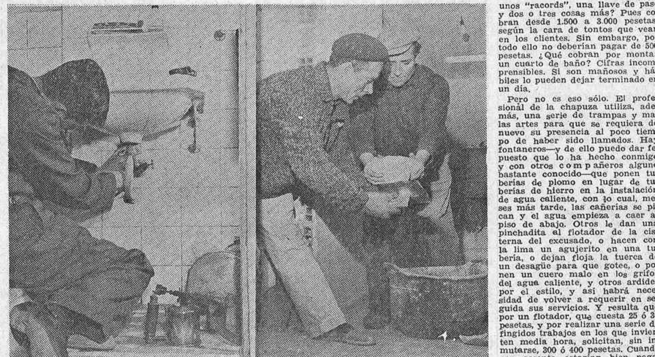
Se comprende que los honrados jornaleros que aparecen en la fotografía no tienen nada que ver con los que se citan en este reportaje. Aclaradas las cosas, he aquí a un fontanero arreglando un lavabo de un cuarto de baño y a dos albañiles que se preparan para ejecutar su obra. (Foto Torremocha.)
