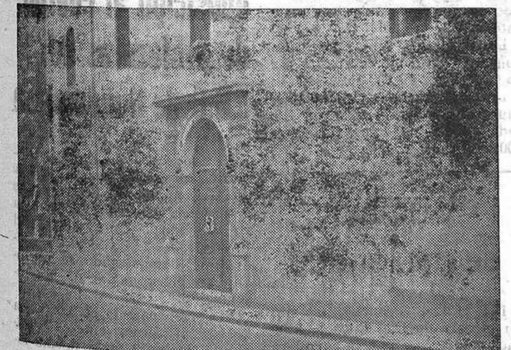
Fachada del desaparecido Convento de las RR.MM. Carmelitas Descalzas, en la calle Ramón y Cajal. Su demolición dio mucho que hablar y escribir.
