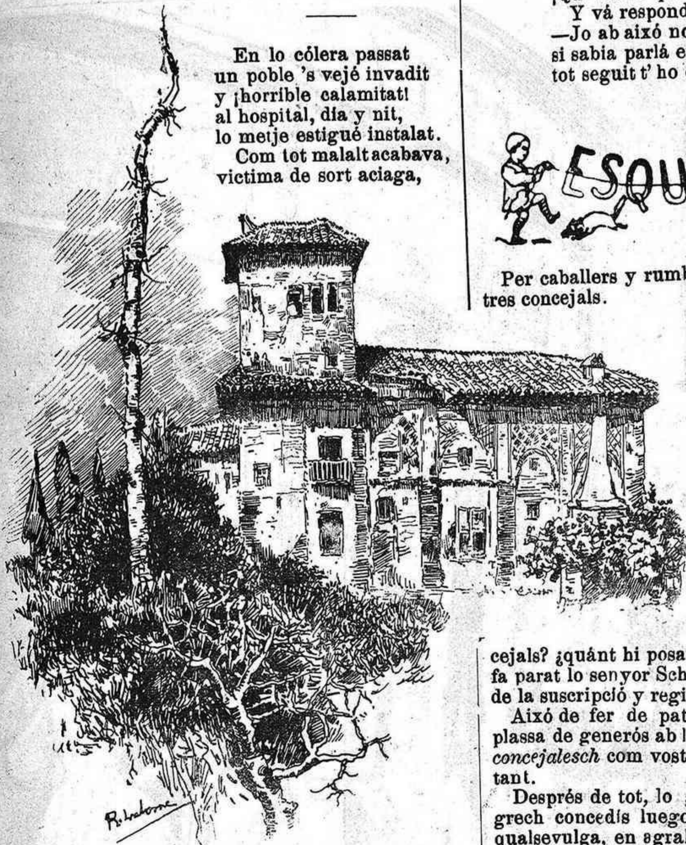
La torre de las Damas (vista desde l' Alhambra)
