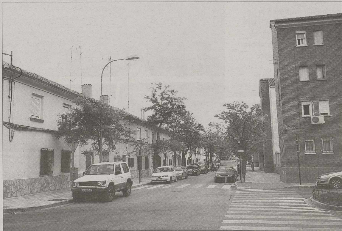
Una de las principales zonas de actuación del Área de Rehabilitación Integral de Santa Teresa. / R. SERRALLÉ
