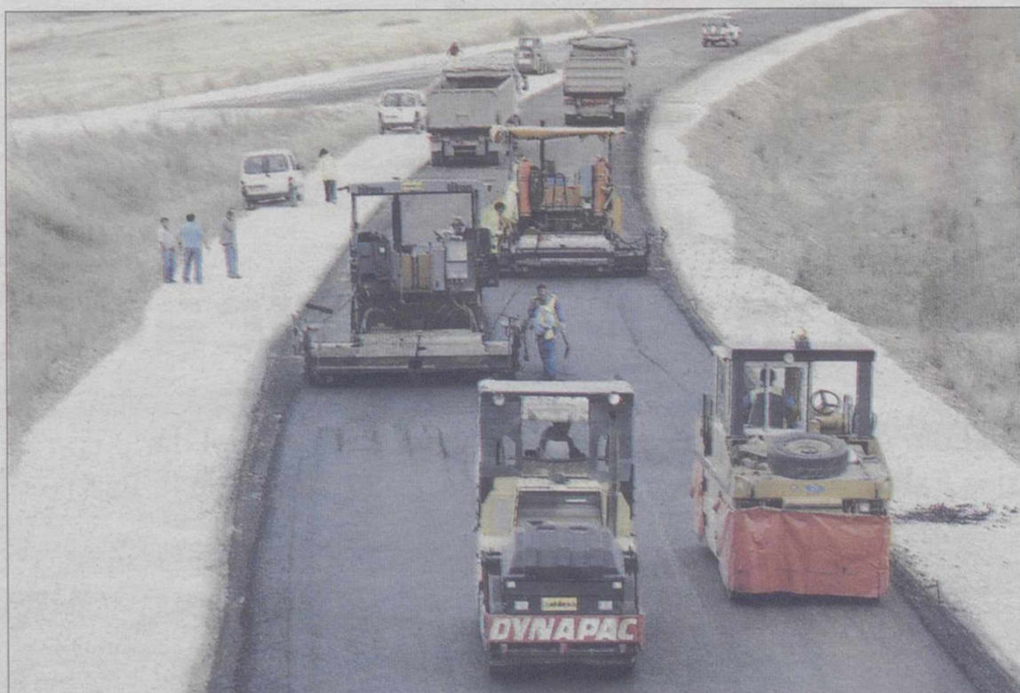
Un equipo de obras públicas asfalta un tramo de carretera. / J.J.M.
