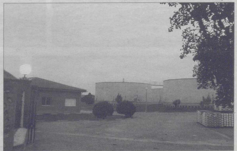
Instalaciones de la Estación Depuradora de Villarrobledo. / T.J.
