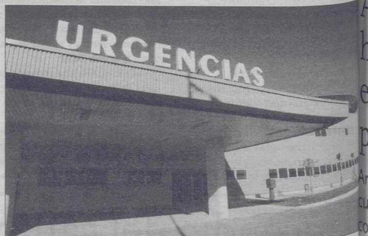
Acceso principal del área de urgencias del Hospital de Villarrobledo. / A.P.
