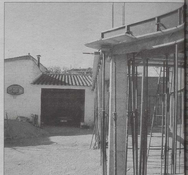
Obras de ampliación./TERESA JIMÉNEZ
