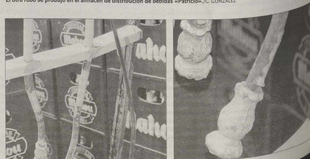
Cortaron los cables telefónicos y rompieron la reja de acceso al almacén de bebidas./G. GONZÁLEZ
