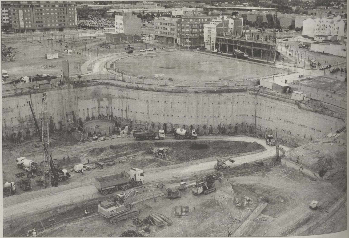
Imagen de las obras del nuevo centro de El Corte Inglés en Albacete. / MANCHAPRESS
