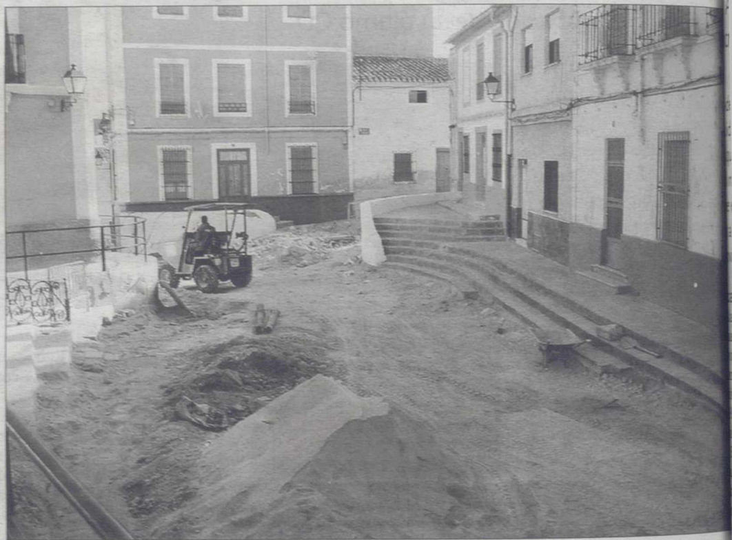
La remodelación de la calle Alfarerías, una de las obras más complejas realizadas últimamente./A. ROMERO
