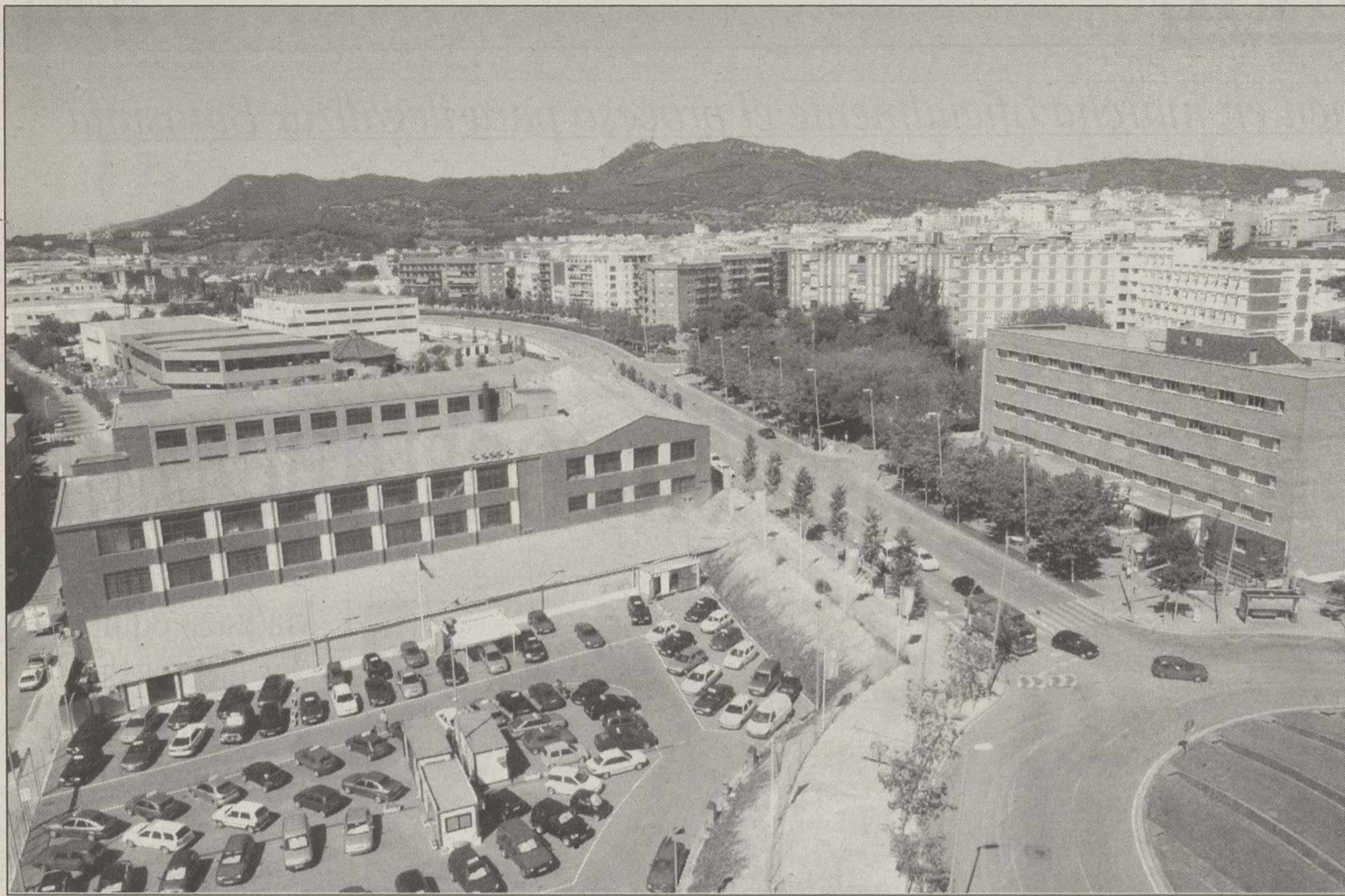
Vista del barrio de Cerdayola de Mataró afectado por un brote de legionella originado en una de las torres de refrigeración.
