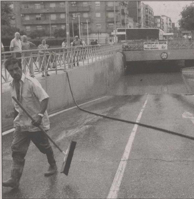
Paso subterráneo inundado en Aldaya.
