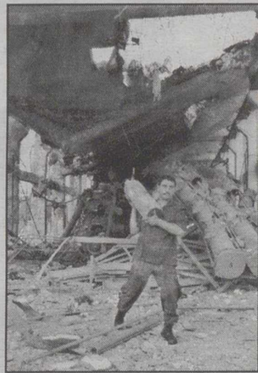
Cuantiosos daños materiales.
