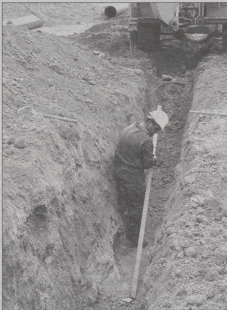
Las obras de mejora del saneamiento e iluminación en el barrio La Estrella ya están en marcha.
