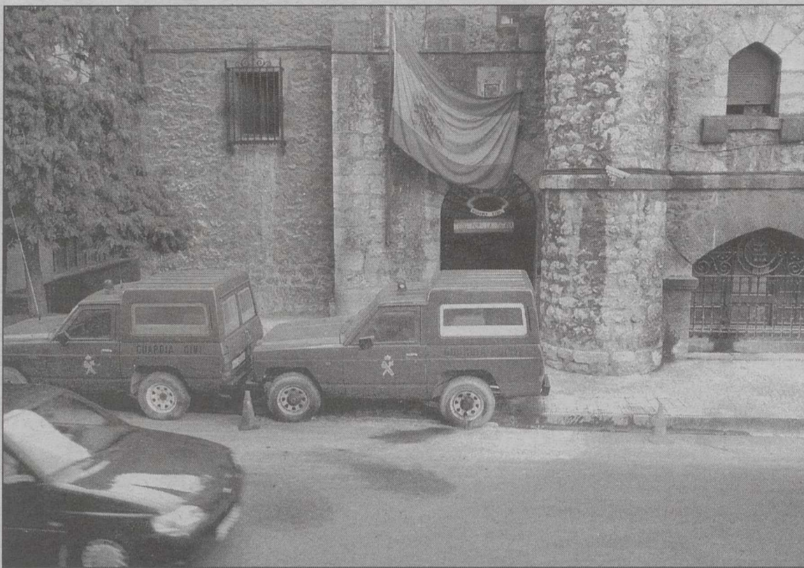
Fachada del cuartel de la Guardia Civil en Ondárroa, atacado ayer de madrugada.
