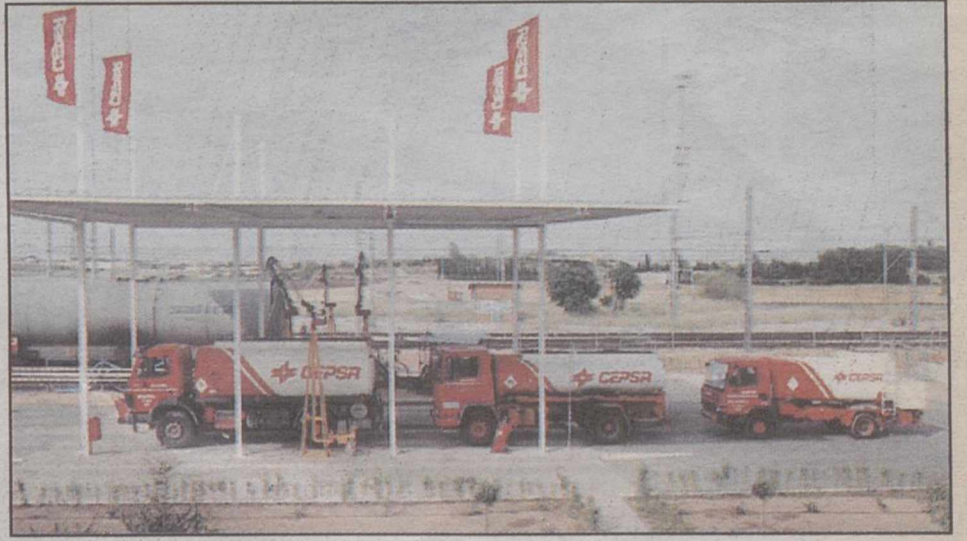
Las isletas de carga pueden proveer a dieciséis camiones al mismo tiempo
