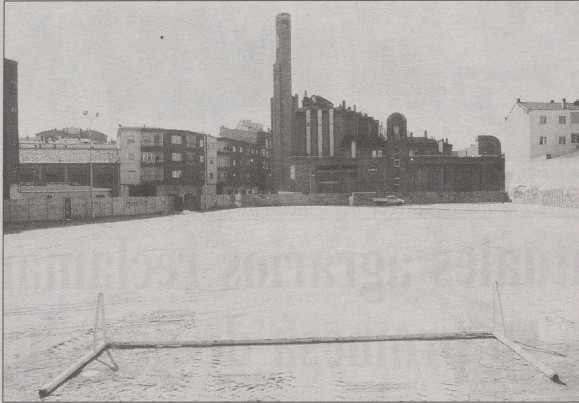
El polideportivo de Juan de Toledo supuestamente iba a estar terminado el pasado verano.
