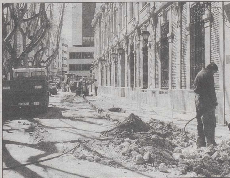
El centro de la ciudad vuelve a estar otra vez en obras.
