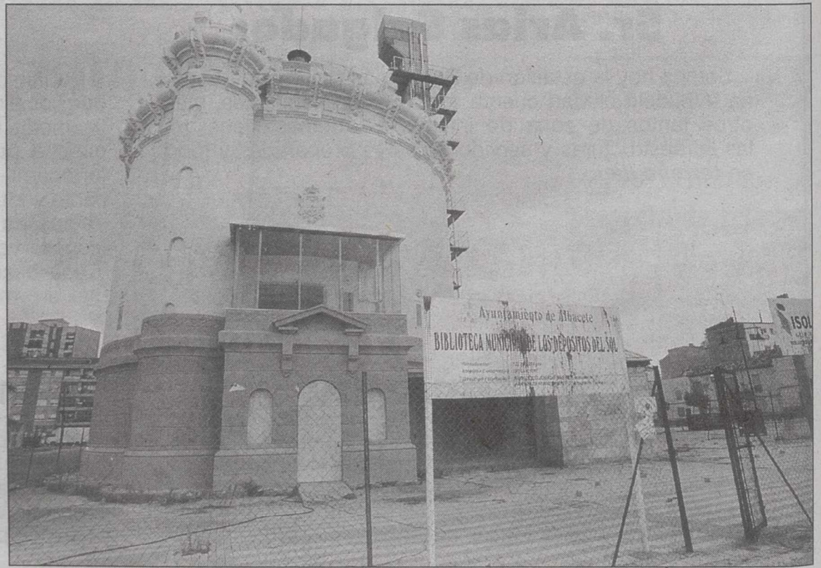
La rehabilitación del Depósito del Sol se ha paralizado por problemas con la empresa contratista.
