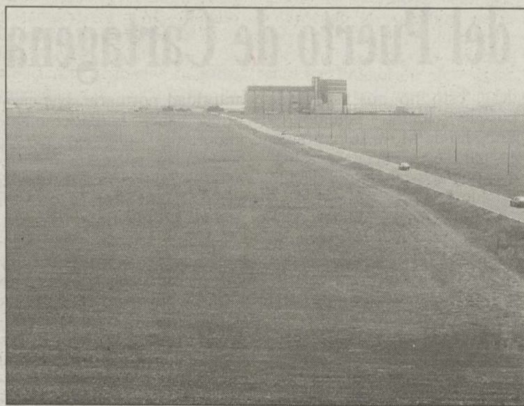
La empresa transportará energía eléctrica desde Higuera hasta Romica.
