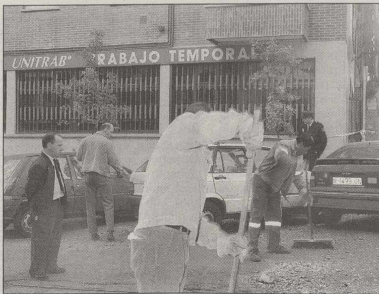
La explosión causó importantes daños materiales.
