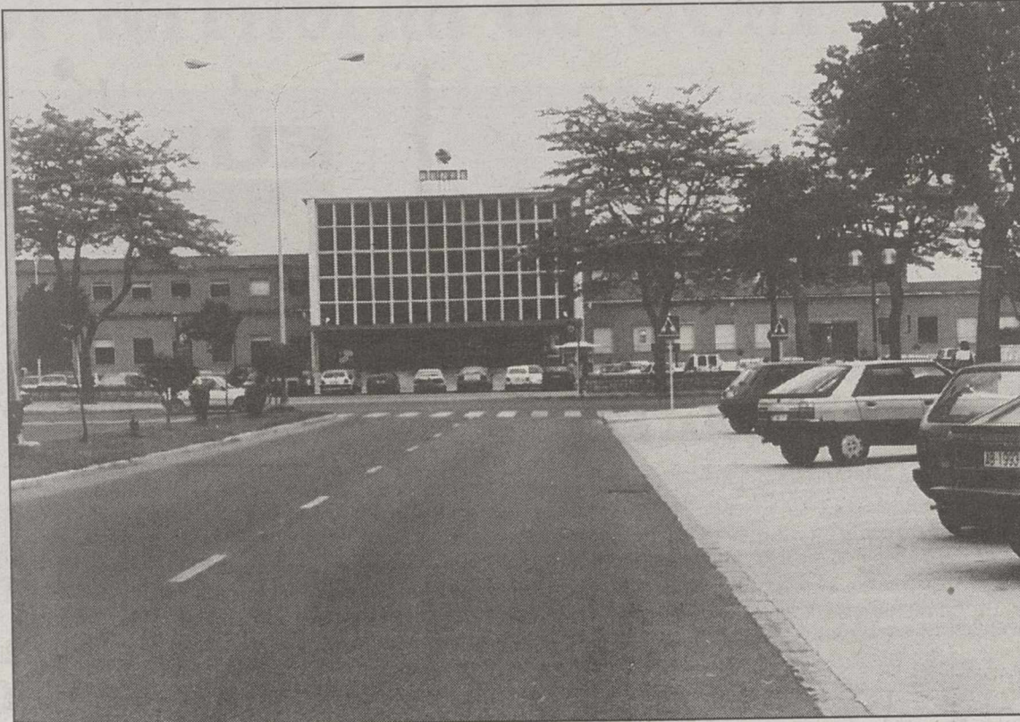
Las actuaciones para mejorar las condiciones ferroviarias de Albacete culminarán con la remodelación de la estación.
