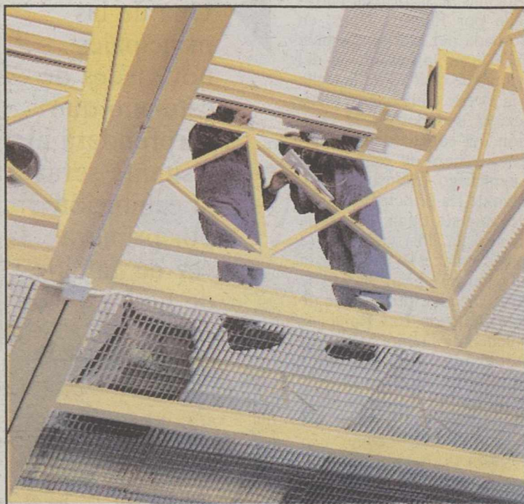
Operarios ultiman detalles en la estructura del techo.
