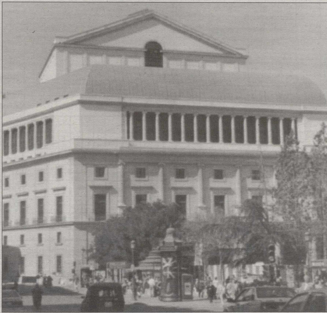
Las obras de remodelación del Teatro Real han costado más de 20.000 millones de pesetas.
