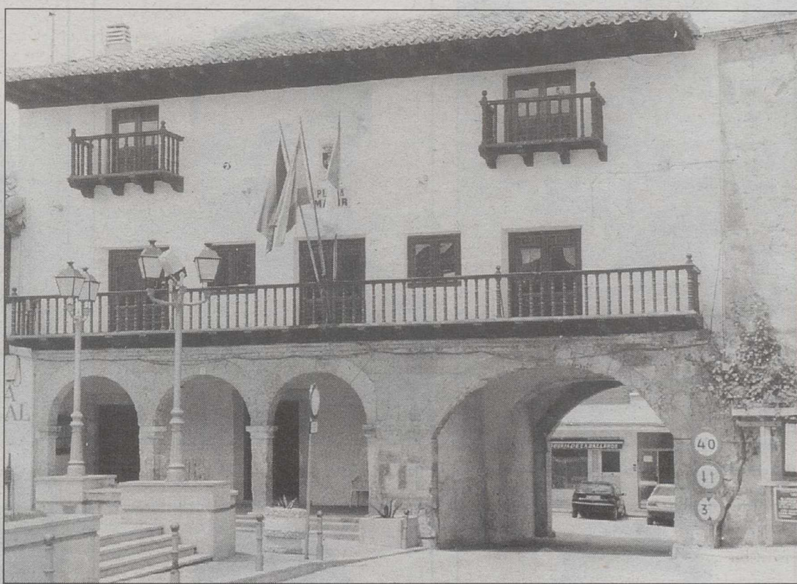
El Ayuntamiento aprobó el proyecto de obra con cargo al F.R.A.M.
