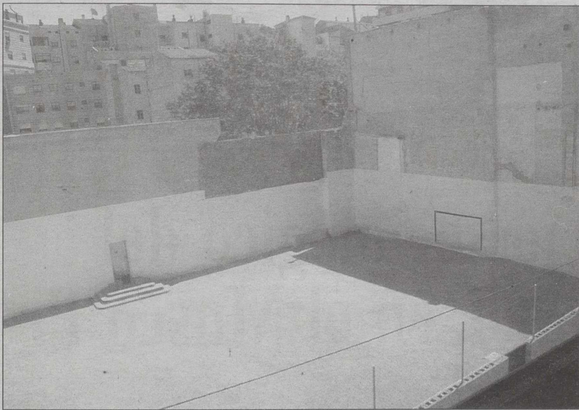
Se ampliará el colegio "Cristóbal Valera" con la creación de ocho aulas y un gimnasio.
