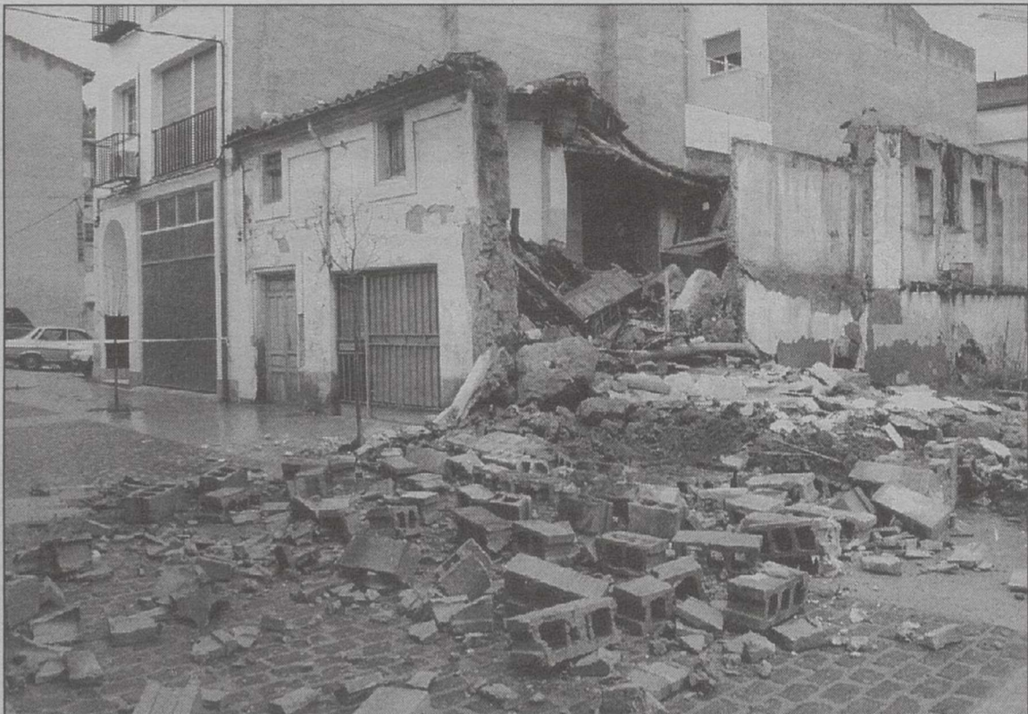
La casa del Barrio Carretas que se hundió hace unos días.
