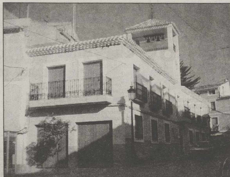
A la vista del informe de la Policía, el Ayuntamiento ordenó parar las obras.
