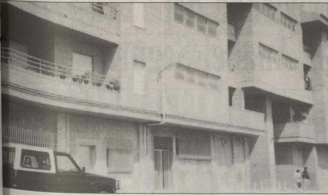
Edificio "San Cristóbal", más conocido como el de "las 112 viviendas", presenta defectos de construcción.
