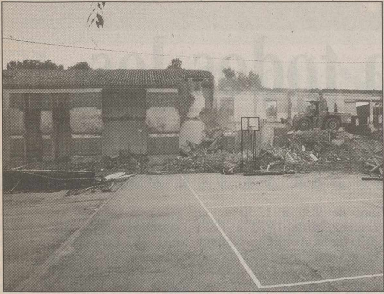
Continúan las labores de desescombro.
