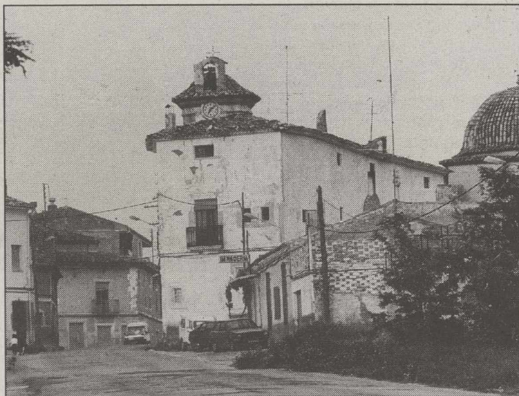
Los vecinos de Isso protestan ante el mal estado del alcantarillado.
